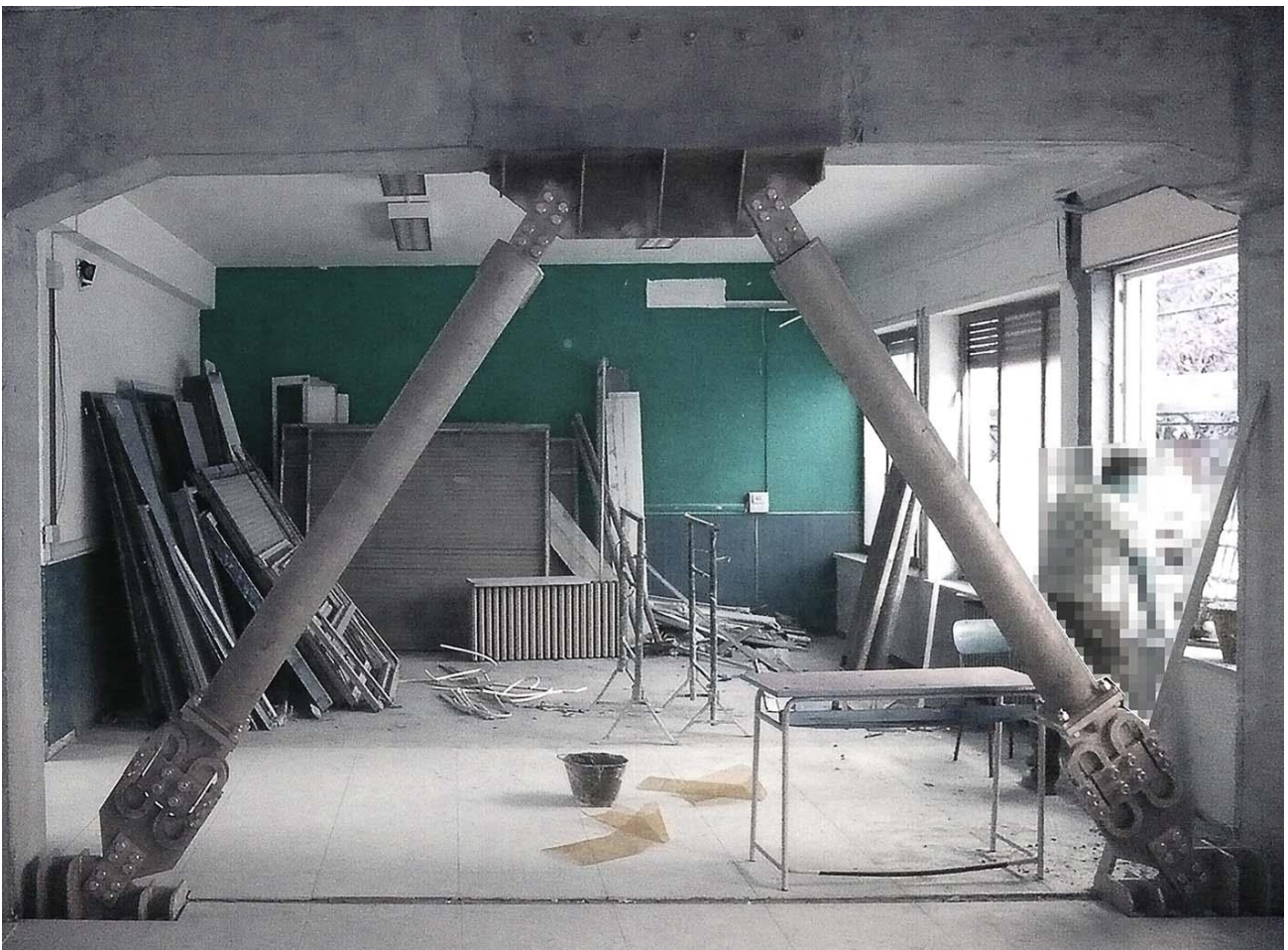
Installazione di controventi dissipativi
