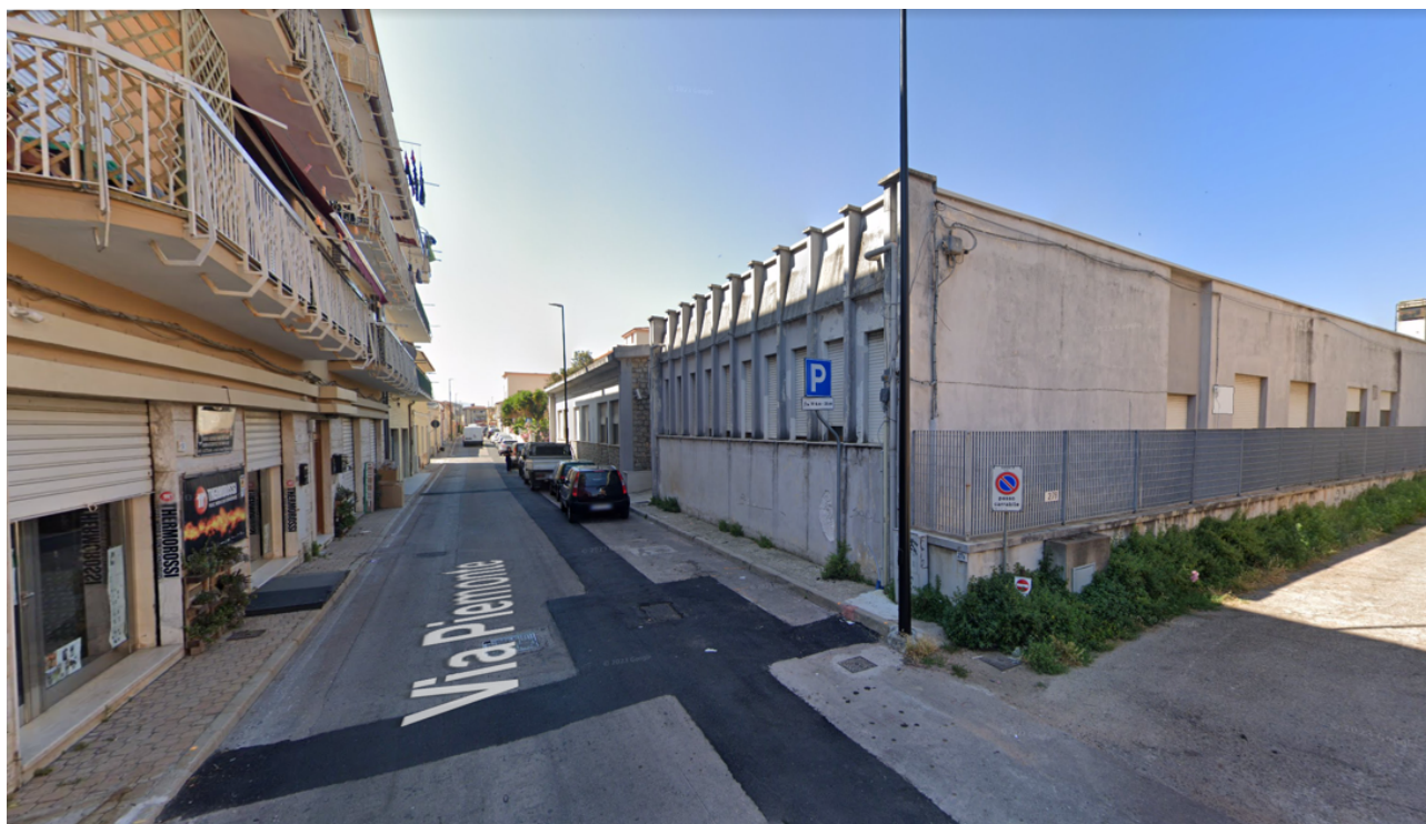
Figura 1 - Fronte Est CPFL, via Piemonte
